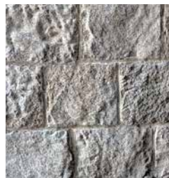
バンダ島隧道の石積み
