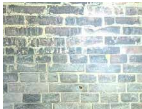
亀瀬隧道のレンガ積み
