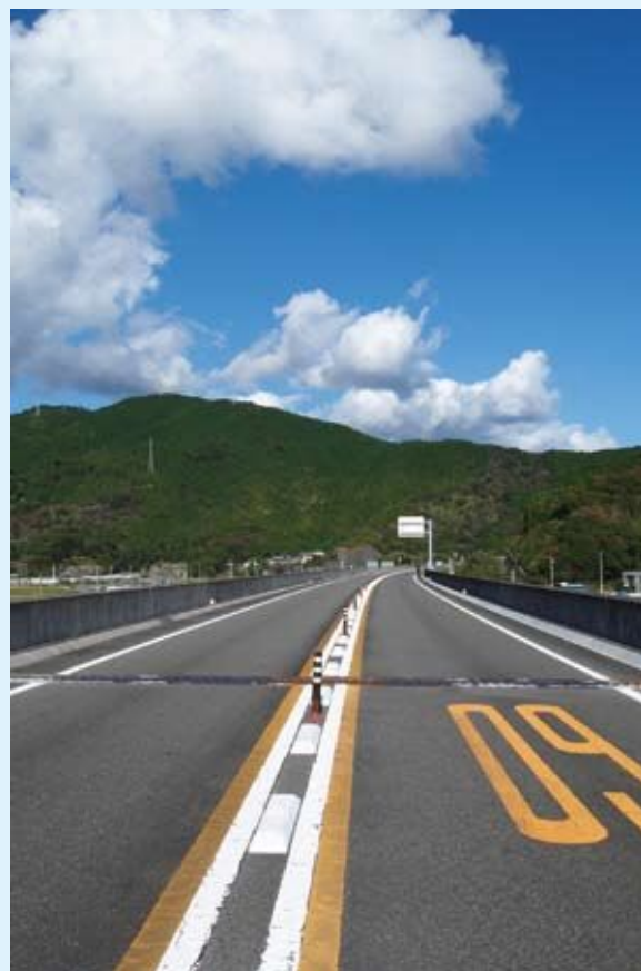
地域高規格道路 北川奈半利道路
