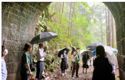
オオムカエ隧道
