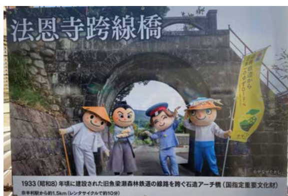
法恩寺跨線橋 (奈半利駅ホーム)
