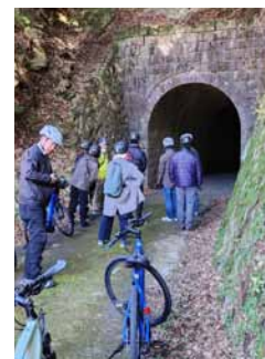
パンダ島隧道(安田町)
