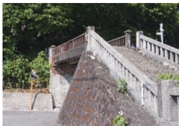
八幡跨線橋 (田野町)
