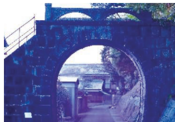
法恩寺跨線橋
